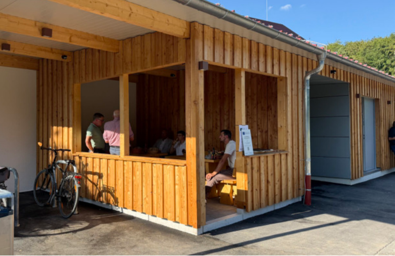
Beim anschließenden Umtrunk verweilten die Gäste in der neu geschaffenen Wanderhütte und konnten den Anbau erstmals in geselliger Atmosphäre erleben. Foto: Stadt Bretten
