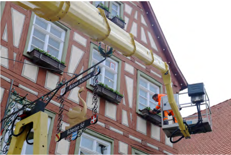
In luftiger Höhe brachte der städtische Baubetriebshof die blühenden Frühlingsboten am Schweizer Hof an. Foto: Gülçin Onat/Stadt Bretten
