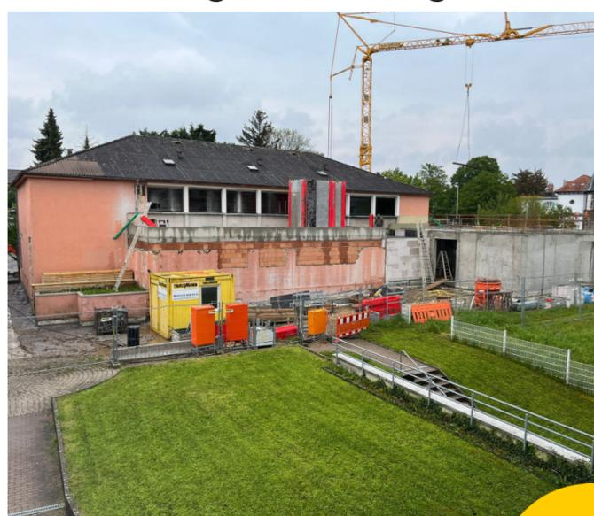
Während die Jahnhalle bereits komplett entkernt ist, entsteht rechts im Bild bereits das Erdgeschoss für die Erweiterung der Hebelschule.
