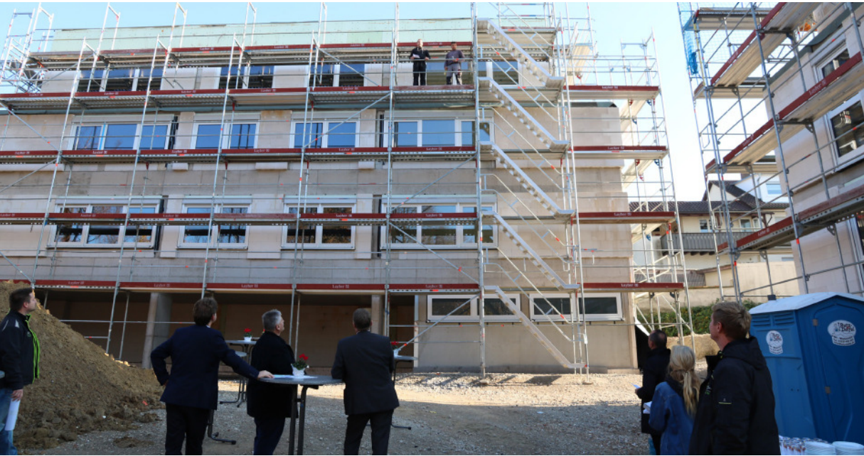
Gespannt hören sich Bürgermeister Michael Nöltner, Gemeinderat Edgar Schlotterbeck, Oberbürgermeister Martin Wolff (alle beim Tisch), Geschäftsführer der Wohnungsbau GmbH Gerd Lehmann (3. v. R.), sowie weitere Anwesende den Richtspruch für die neuen Wohneinheiten beim Wannengeweg an.
