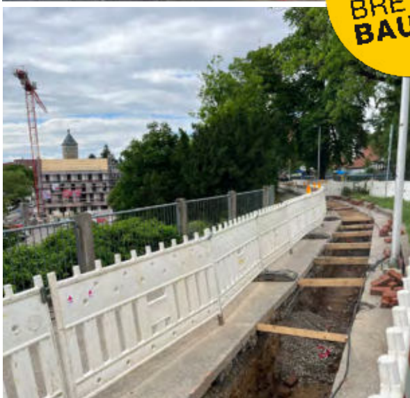
Brunnen und Baumquartiere sorgen zukünftig für Abkühlung und mehr Aufenthaltsqualität an der Pforzheimer- und Weißhofer Straße. Daneben laufen die Erweiterung des Wärmenetzes (z. B. Promenadenweg) und der Ausbau der Photovoltaik auf Hochturen. Fotos: Stadt Bretten
