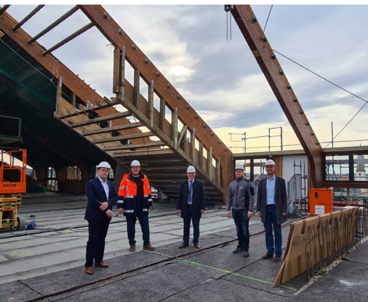
Das Dach des Bronnerbaus ist schon zu großen Teilen abgetragen. Insgesamt gehen die Arbeiten am Melanchthon-Gymnasium in die Endphase. Foto: Marcel Winter/Stadt Bretten
