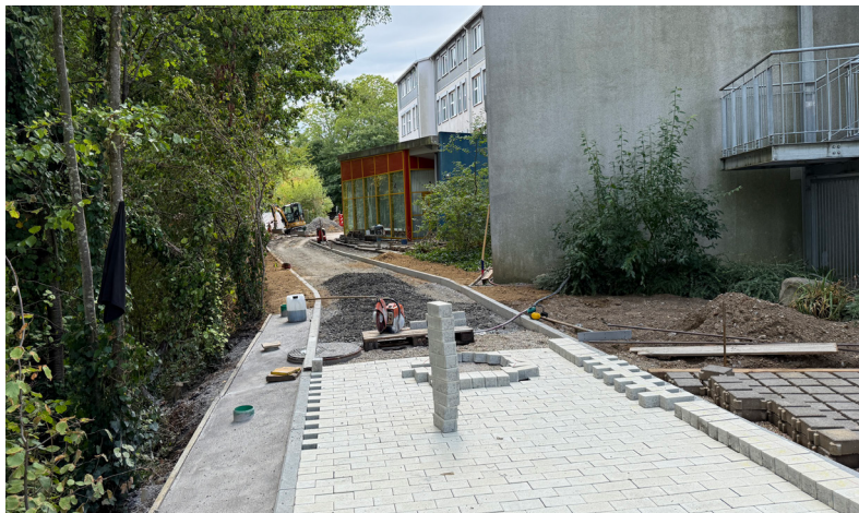
Beim Neubau des rund 80 Meter langen Radwegs entlang der Weißach laufen derzeit die Pflasterarbeiten. Foto: Stadt Bretten
