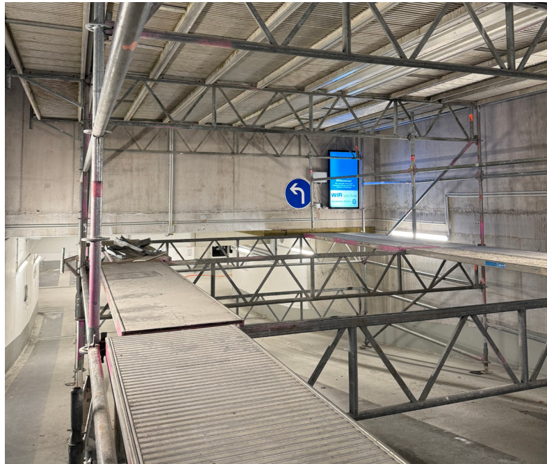
Bereits in der Einfahrt der Tiefgarage Sporgasse sind die laufenden Nachrüstungsarbeiten sichtbar. Gerüste werden unter anderem für die Arbeiten an Wänden und Decken eingesetzt. Foto: Stadt Bretten
