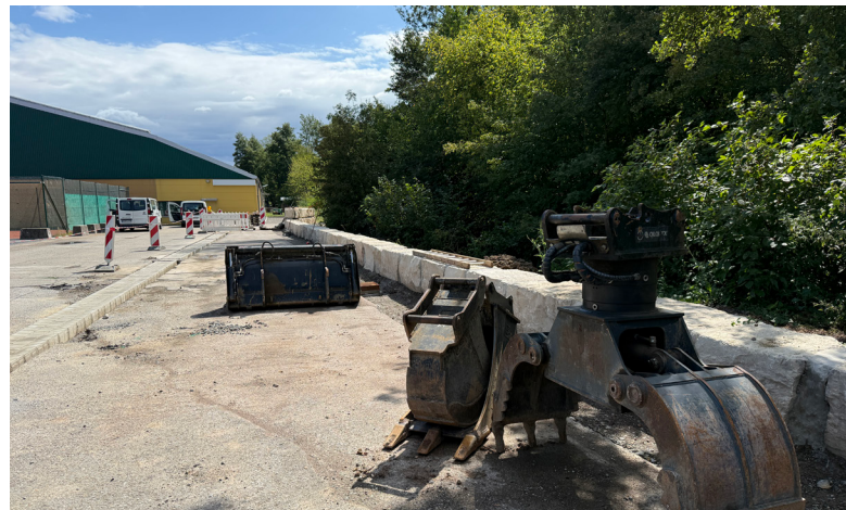
Im Bereich des Reitclubs und des Tennisclubs Blau-Weiß Bretten entsteht entlang der Weißach eine rund 270 Meter lange Hochwasserschutzmauer. Foto: Stadt Bretten
