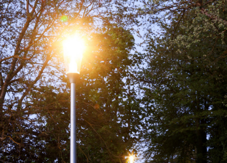
Umrüstung auf LED: 904 Straßenleuchten wurden im ersten Bauabschnitt durch energieeffiziente LED-Leuchten ersetzt. Foto:Tom Rebel
