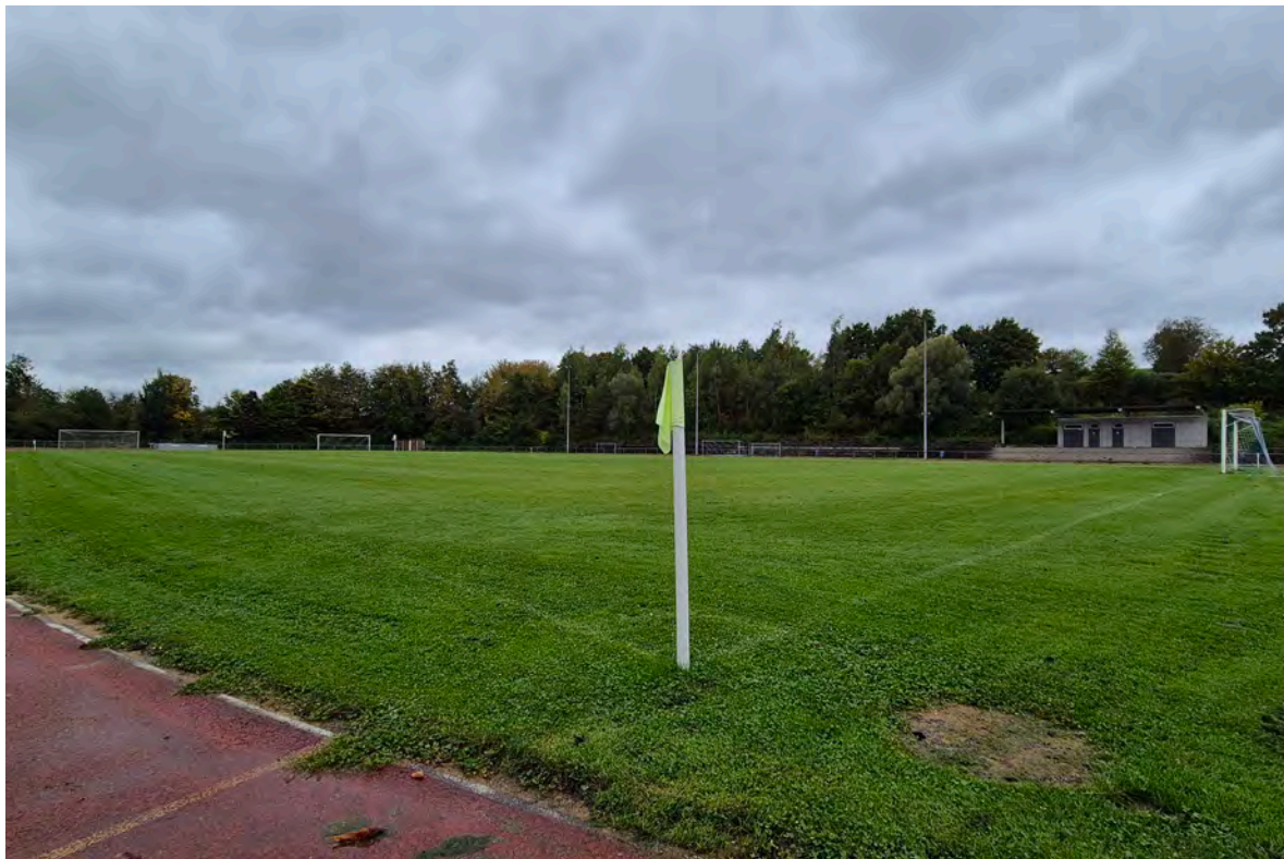
Die Tage des Rasenplatzes im Stadion sind so gut wie gezählt. Wenn der Gemeinderat am kommenden Dienstag die Vergabe der Bauleistungen beschließt, kann der Bau des Kunstrasenplatzes noch in diesem Herbst beginnen. Foto: Marcel Winter/Stadt Bretten
