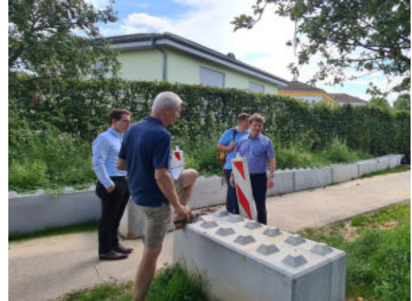
Im Steiner Pfad wurde der Schutz vor Starkregenereignissen verbessert. Foto: Marcel Winter/Stadt Bretten
