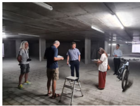
Die Tiefgarage auf dem Sporgassenareal soll im Dezember beparkt werden können. Foto: Marcel Winter/Stadt Bretten
