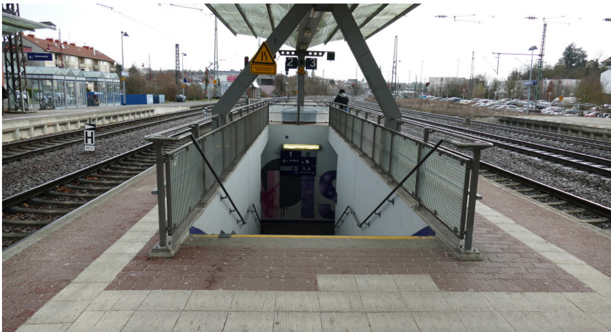
Der Zugang über Treppen am Brettener Bahnhof heute. Ab 2024 wird es neben den Treppen an den Bahnsteigen von Gleis 1, 2/3 und 4/5 Aufzüge geben und mit der Markierung der Stufen und einem Blindenleitsystem wird die Barrierefreiheit gewährleistet.
