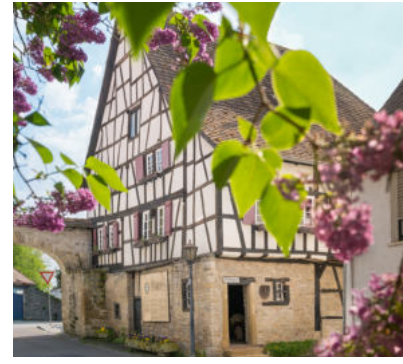
Das Gerberhaus vor und nach den Umbauarbeiten. Fotos: Stadt Bretten (o.); C. & G. Herr (u.)
