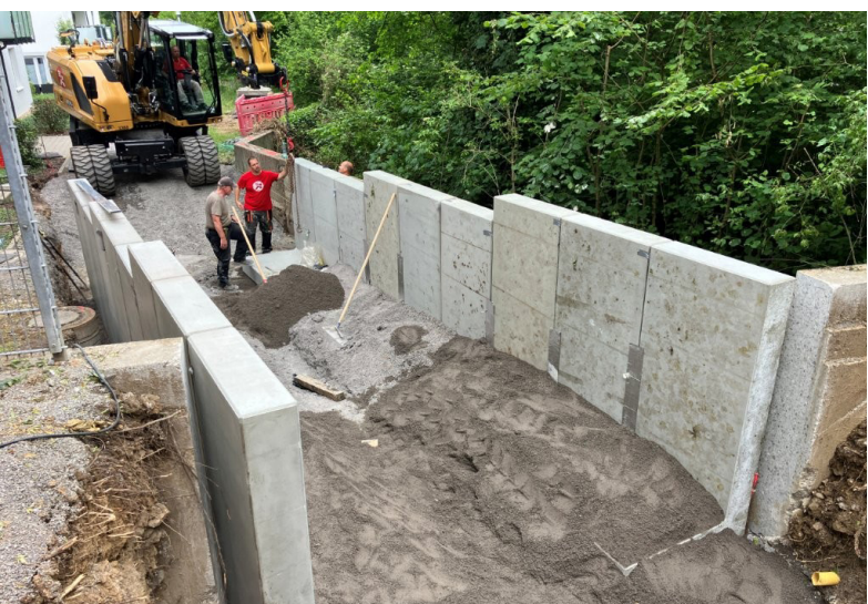
Bauarbeiten für die neue Radweg-Rampe hinter dem Edith-Stein-Gymnasium während der Pfingstferien
