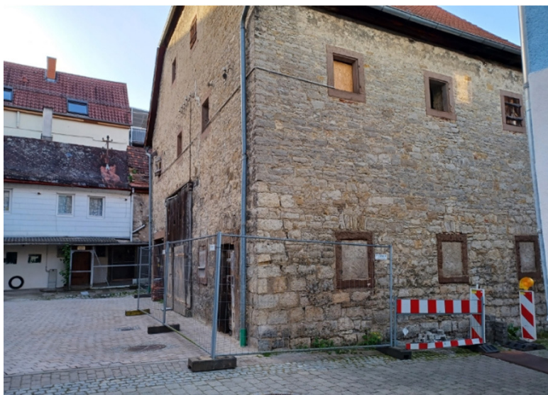
Die Steinscheune in der Wassergasse ist ein bedeutendes Zeugnis der Brettener Stadtgeschichte und soll statisch ertüchtigt werden.
