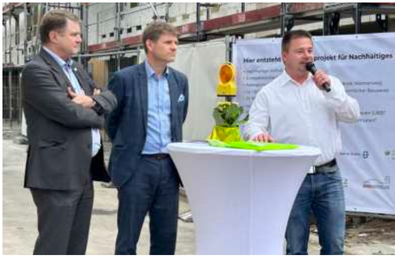
Die Baustellenbegehung in der Kleiststraße 6 stieß auf große Resonanz. Foto: Stadt Bretten
