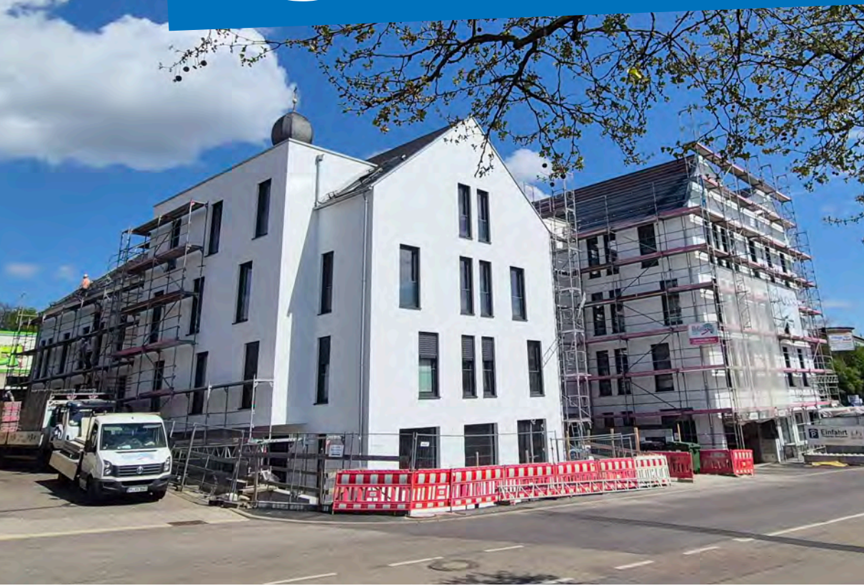
Ein Teil des Gerüsts am neuen Gesundheitszentrum an der Sporgasse wurde bereits entfernt. An den weiteren Gebäudeteilen laufen die letzten Fassadenarbeiten, so dass diese in den kommenden Tagen ebenfalls vom Gerüst befreit werden. Foto: Marcel Winter/Stadt Bretten
