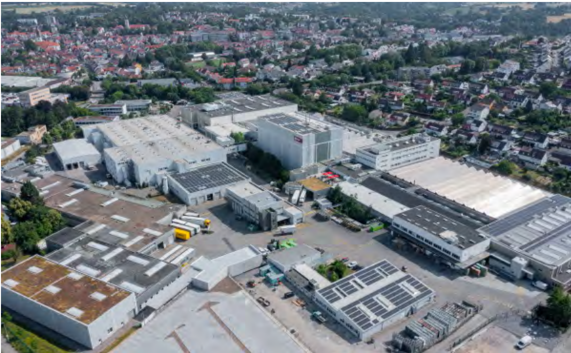
Das Werk von Neff im Ruiter Tal, das in seinen Grundzügen bereits im Jahr 1950 entstand, ist aus Bretten nicht wegzudenken. Die „Weiße Ware“ ist ein Inbegriff der Brettener Identität geworden.
