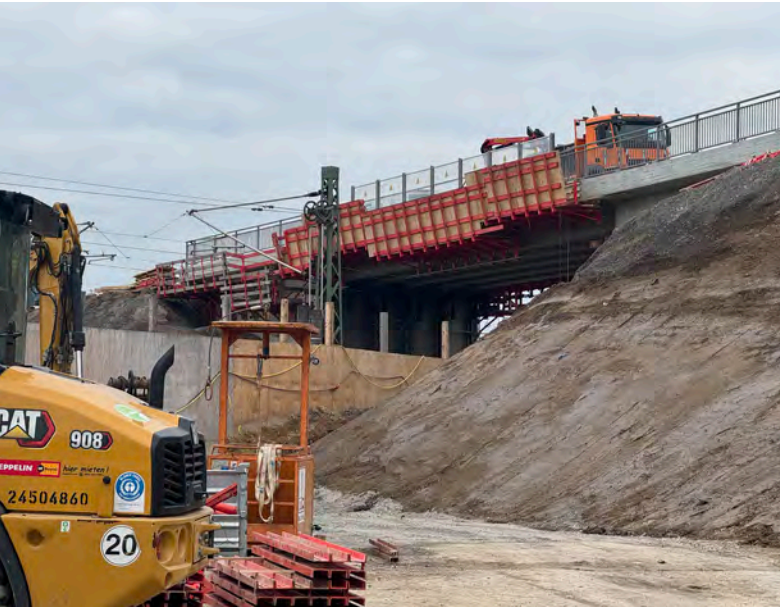
Die Bauarbeiten an der B35 dauern weiter an. Foto: Ellen Reinold/Stadt Bretten
