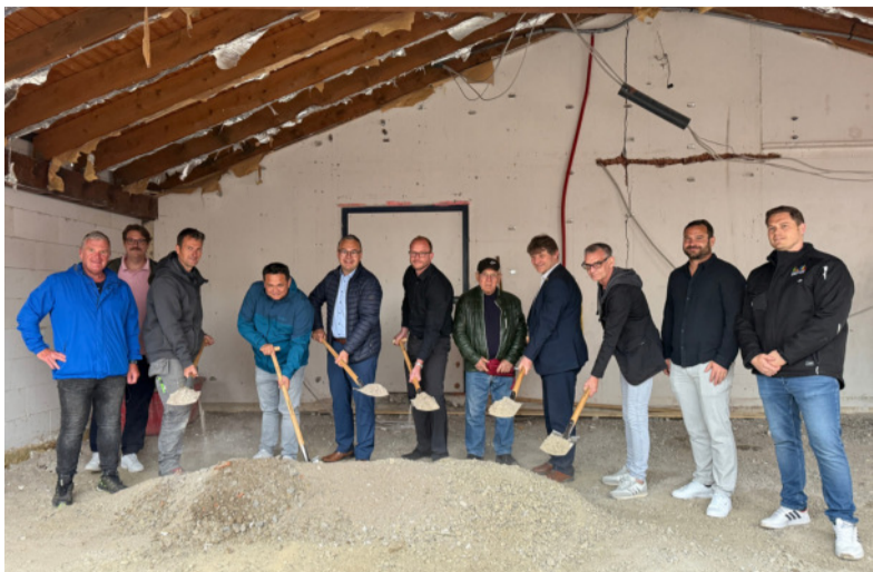
Mit dem symbolischen Spatenstich in Rinklingen gaben Oberbürgermeister Nico Morast, Bürgermeister Michael Nöltner, Dezernent Peter Maag, Ortsvorsteher Timo Hagino sowie Vertreter der beteiligten Firmen und der ehrenamtlichen Helfer den Startschuss für den Neubau des Gemeindesaals. Foto: Celina Faber/Stadt Bretten
