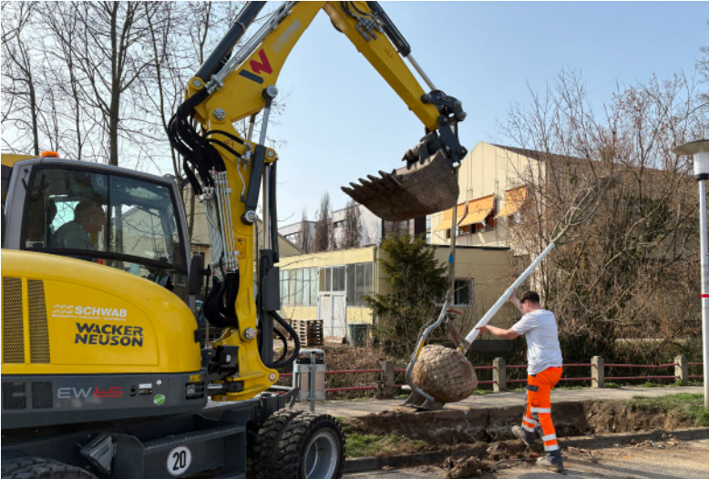
Für die Pflanzung größerer Bäume, wie hier am Seedamm, wird schweres Gerät benötigt. Foto: Ellen Reinold/Stadt Bretten
