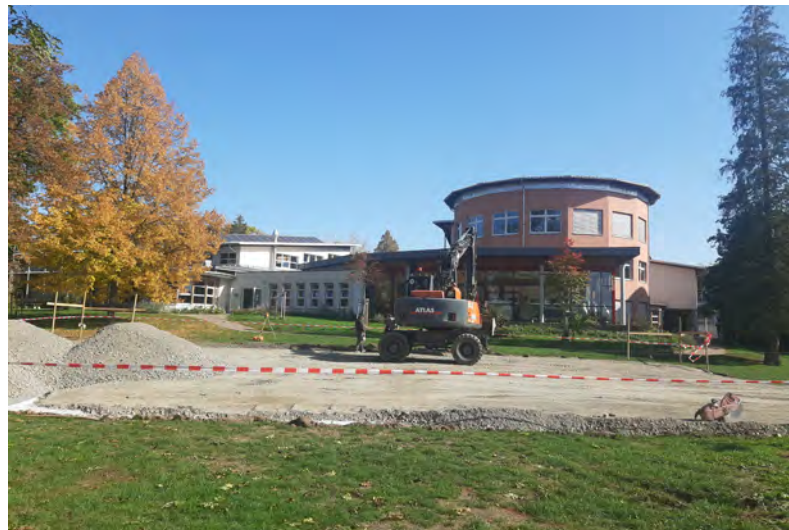
Im Stadtpark nahe der Hebelschule wird eine Fläche für die Platzierung von mobilen Raumeinheiten vorbereitet, um vorübergehend mehr Platz für den Unterricht und die Nachmittagsbetreuung zu schaffen. Foto: Stadt Bretten
