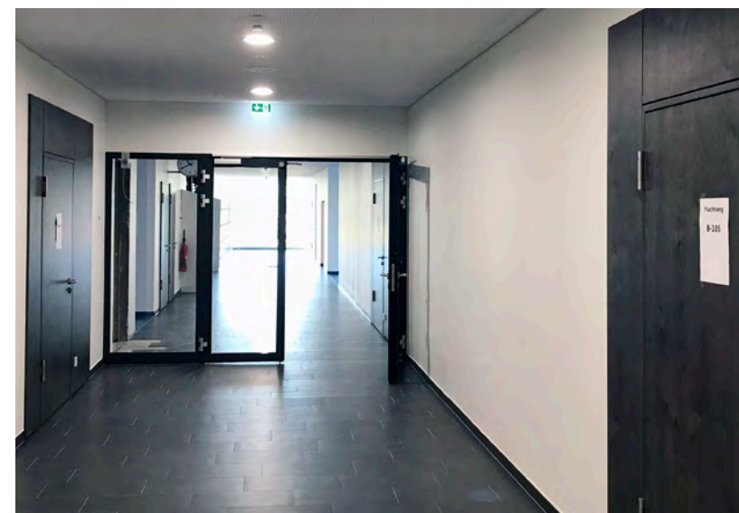
Neue Alu-Glas-Türelemente sorgen im Melanchthon-Gymnasium nicht nur für einen breiteren Durchgang, sondern auch für mehr Licht im Flur.
