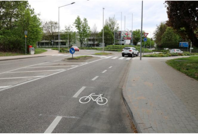
Der Radverkehr wird vor dem Kreislauf auf die verengte Fahrbahn geführt. So wird mehr Aufmerksamkeit für den Radverkehr erzeugt und die Gefahr eines Fahrens im toten Winkel des motorisierten Verkehrs verhindert.
