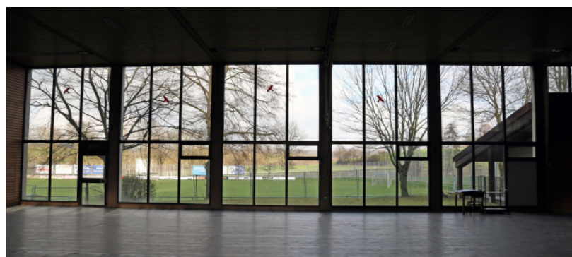
Im Rahmen der Sanierung wird die jetzige Glasfassade, die so genannte Pfosten-Riegel-Konstruktion, durch eine dreifachverglaste Ausführung mit insgesamt drei Brandschutztüren ausgetauscht, um Personen im Notfall innerhalb kürzester Zeit aus dem Raum evakuieren zu können.
