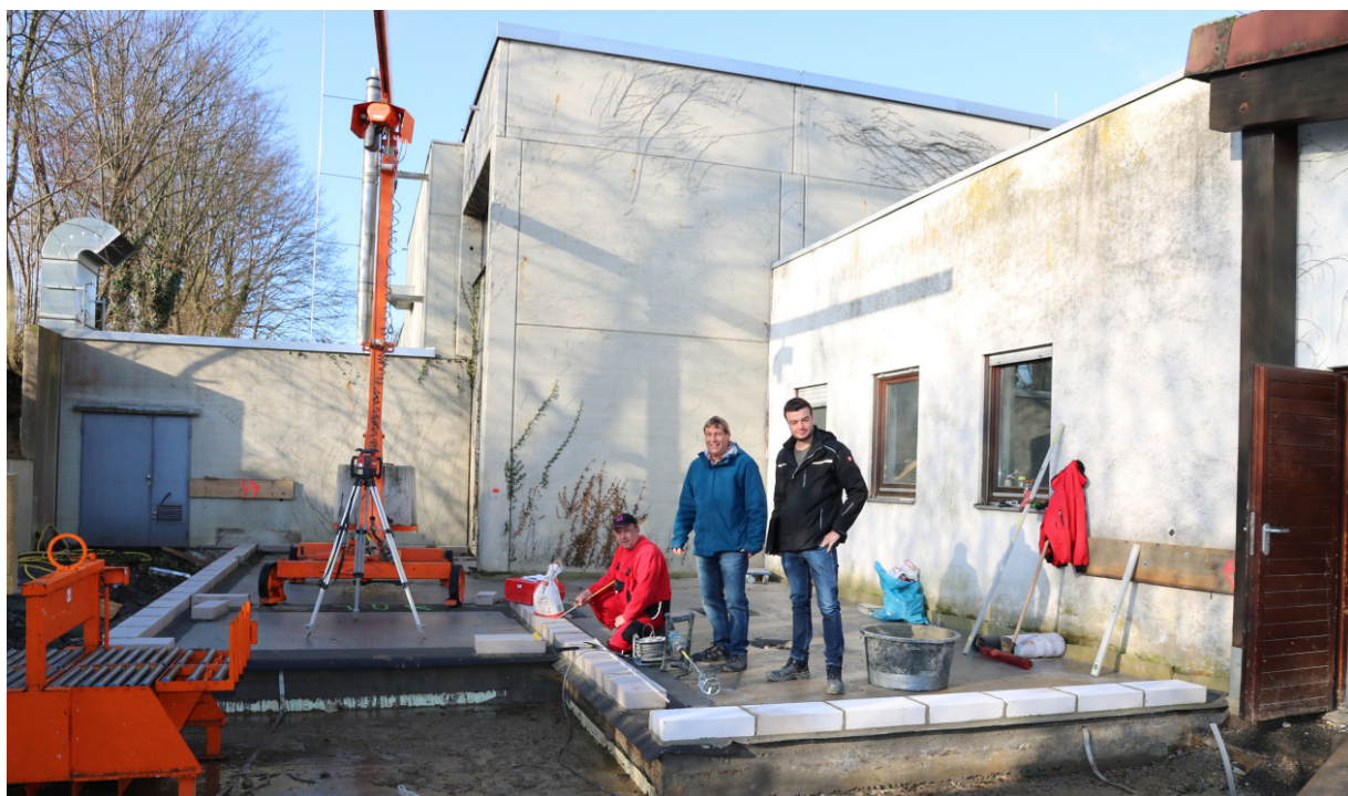
Aktuell finden unter anderem Arbeiten für den Küchenanbau statt, die von Projektleiter Kai de Bortoli (Mitte) des Amtes "Bauen, Gebäudemanagement und Umwelt" und dem Bauleiter Marco Roth (rechts) von ARC Architekten aus Karlsruhe koordiniert und beaufsichtigt werden.
