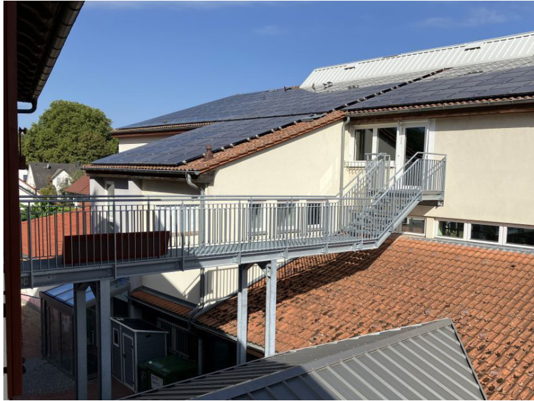
Der neue Rettungssteg an der Grundschule Rinklingen dient künftig als zweiter baulicher Rettungsweg für das Obergeschoss der Schule und des Kernzeitgebäudes. Foto: Stadt Bretten
