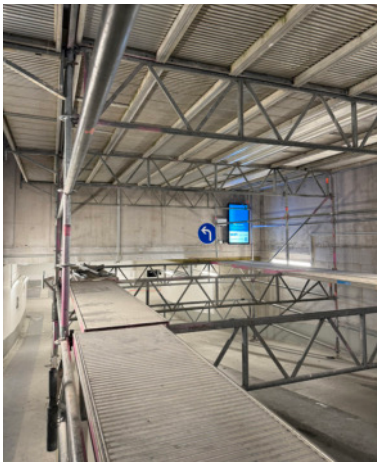
Die Arbeiten an der Tiefgarage Sporgasse laufen weiter. Die Wiedereröffnung ist voraussichtlich für den 24. September 2026 vorgesehen. Foto: Stadt Bretten
