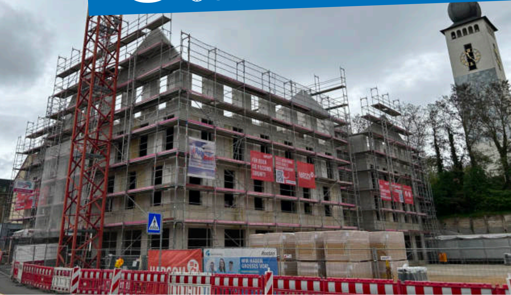
Das neue Gesundheitszentrum in der Sporgasse nimmt Form an.
