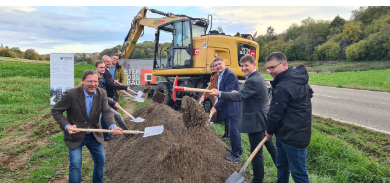
Mit dem ersten Spatenstich gaben Oberbürgermeister Martin Wolff, Bürgermeister Michael Nöltner sowie Vertreter der beteiligten Landkreise und der Gemeinde Neulingen sowie der ausführenden Firmen den Startschuss für die Bauarbeiten. Foto: Stadt Bretten
