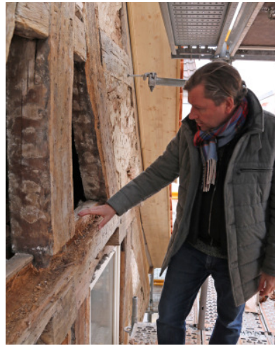
Während der Besichtigung erläuterte Architekt Frank Morlock auch die Arbeiten an der Außenfassade, deren Holzbalken von Nägeln befreit und abgeschliffen wurden. Marode Stellen wie an diesem Fenster, an dem Spuren des ursprünglichen hellgrauen Holzanstrichs gefunden wurden, werden aktuell gerichtet.
