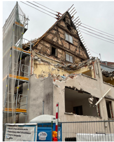
Nach dem Abbruch des alten Anbaus aus den 1970er Jahren wird in den kommenden drei Monaten ein neuer filigraner Stahlbau mit integriertem Aufzug errichtet. Foto: morlock, architekten + generalplaner
