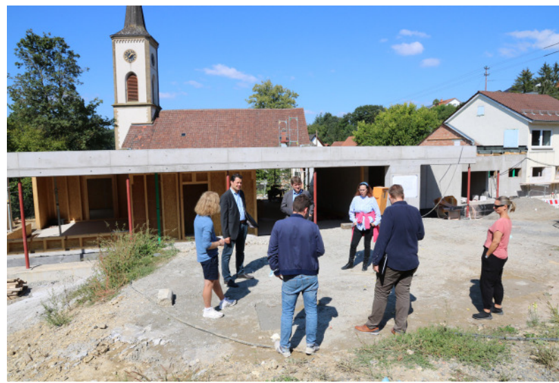
Im Anschluss an das Bestandsgebäude (hier rechts) entsteht ein großzügiger Anbau in Holzbauweise, der ebenfalls im Rahmen der Baustellenbegehung besichtigt wurde.
