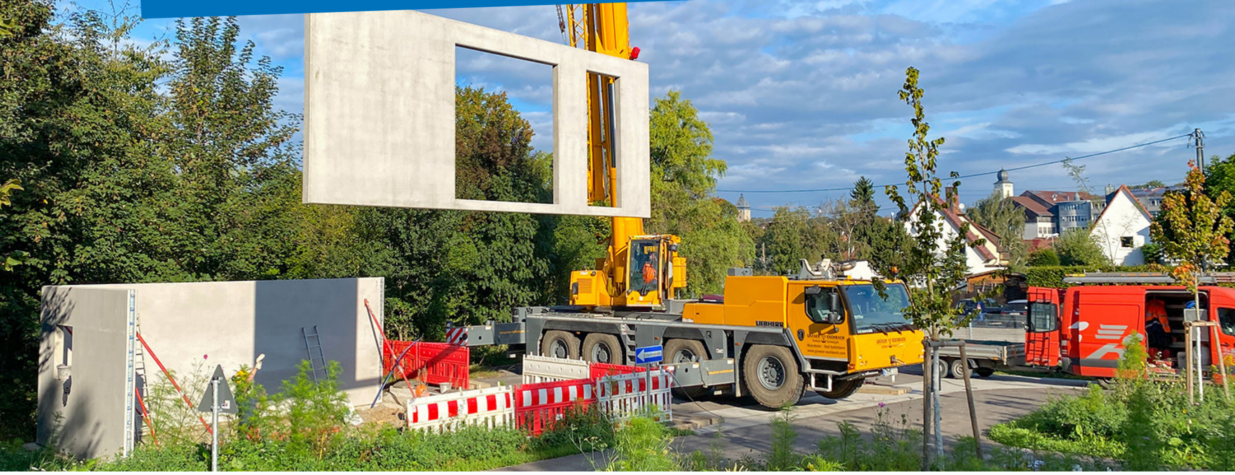
Das Inventar-Gebäude auf dem Jugendverkehrsübungsplatz hat die Firma Harsch aus ressourcenschonendem recyceltem Beton erstellt. Ende September wurden die Fertigteile verladen und zusammengefügt. Ende Oktober ist das Gebäude schlüsselfertig.
