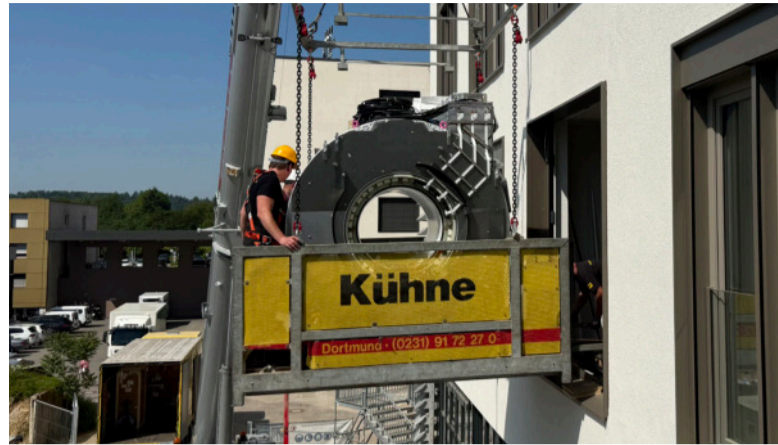
Spektakulärer Moment vor dem Einbau: Das MRT-Gerät wurde über den Dächern Bretten in Position gebracht. Foto: Elisabeth Kremer/Stadt Bretten
