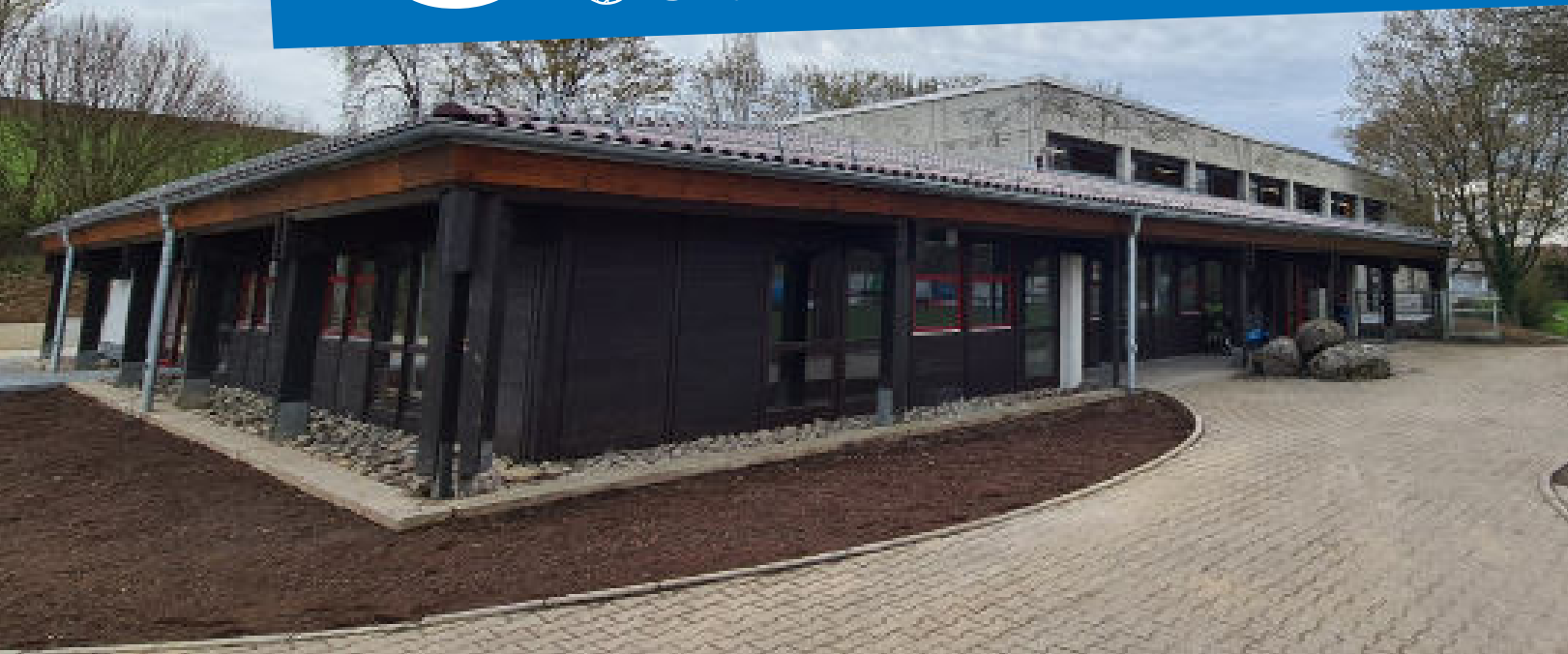
Die Neibsheimer Talbachhalle wurde im Jahr 1982 errichtet. Entsprechend hoch war der Sanierungsbedarf, insbesondere im energetischen und sanitären Bereich. Die Kosten für den Umbau lagen bei 2,5 Millionen Euro, wobei 705.000 Euro über Fördermittel generiert werden konnten.
