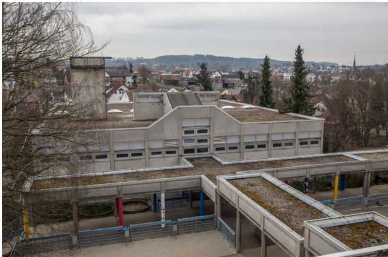
Die Schwandorf-Grundschule in Diedelsheim: Im Zuge der Sanierung von Bauteil B soll künftig auch die Klimatisierung der Räume verbessert werden.
