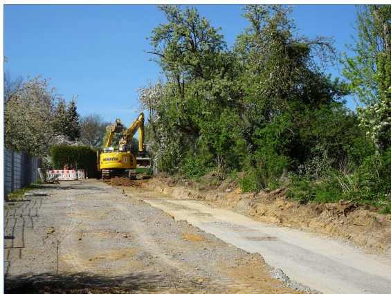
2: Rohrverlegung 2017 innerhalb des südlichen Feldweges. Hier im Bereich der alten Obstbäume.
