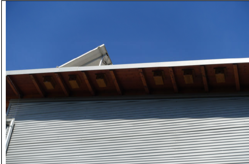
Foto 7: Unter dem Flachdachvorsprung des östlichen Fachbaus angebrachte sechs Nistkästen für Mauersegler.
