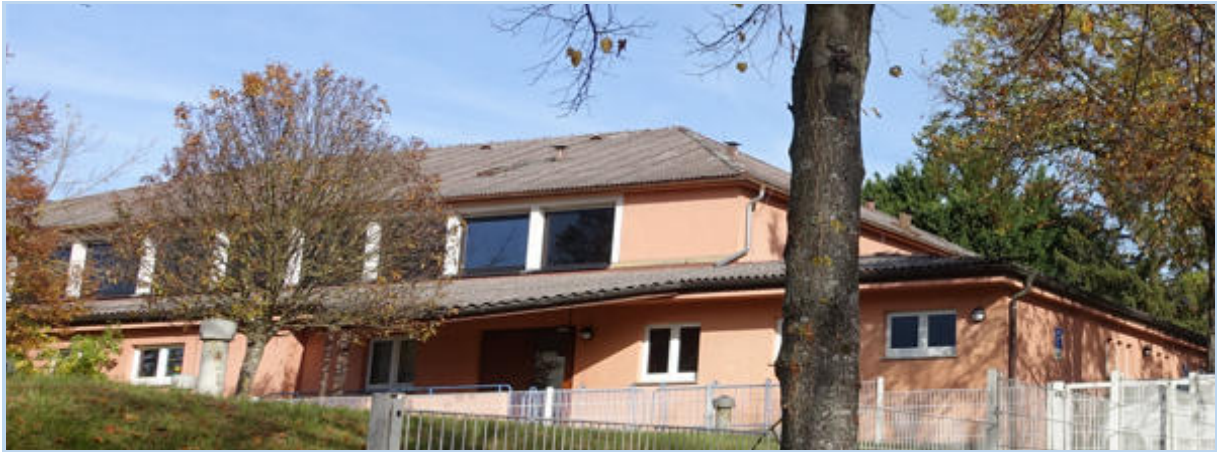
Foto 1: Blick auf die Jahnhalle mit Eingangsbereich im Süden. Davor die Wiese des stillgelegten Hochbehälters der städtischen Wasserversorgung.
