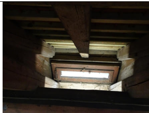
Foto 10: Die kleinen verschlossenen Fenster der Dachgauben, die etwas Licht in den Dachstuhl bringen. Nur hier befinden sich Spinnennetze.
