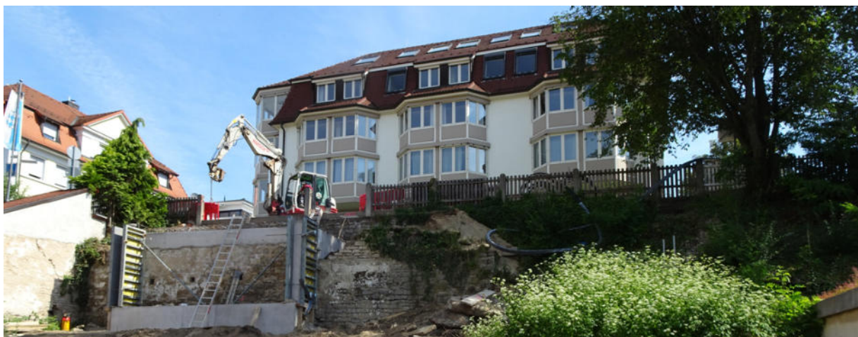
Abb. 3: Blick vom Parkplatz auf den Fundamentbau des Trafohäuschens. Im Hintergrund das Altenheim.
