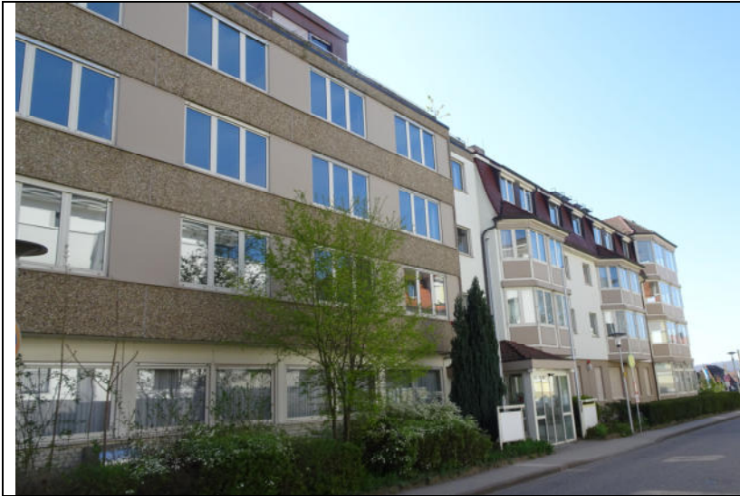
Foto 4: Das Altenheim mit seinen zwei unterschiedlichen Bauweisen entlang der Apothekergasse mit schmalen Grünstreifen.
