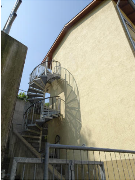
Foto 3: Blick auf die seitliche Fluchttreppe und links die hohe Betonstützmauer.
