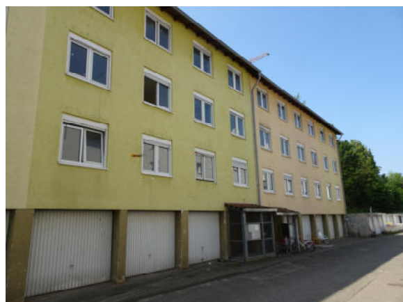
Foto 2: Das Wohngebäude Nr. 6 südlich der Kleiststraße mit Garagen im Erdgeschoss.
