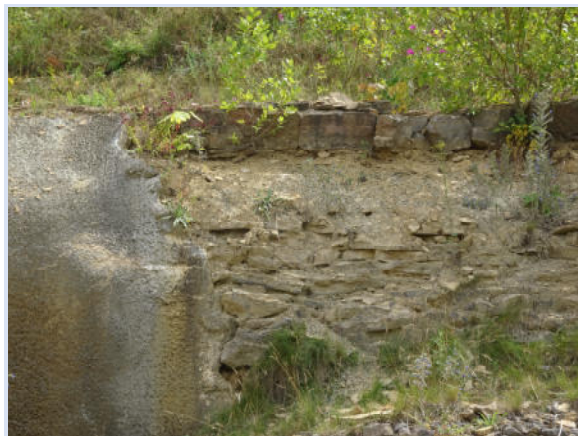
Foto 5: Steilere offene Muschelkalkwände wurden zum Bau des Gebäudes mit Beton „gesichert“.
