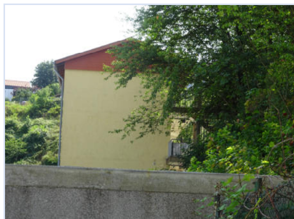
Foto 8: Blick von den Stellplätzen über die Garagen zum Wohngebäude Nr. 6.
