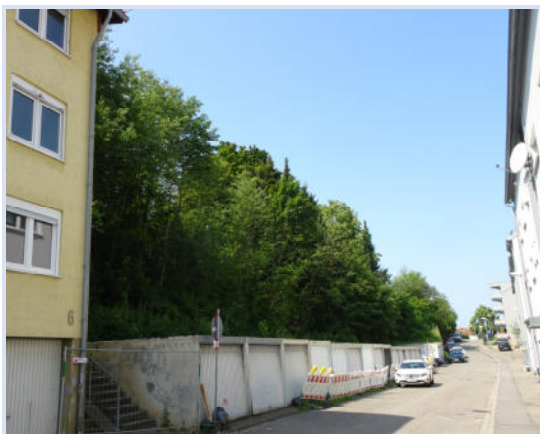
Foto 1: Blick auf die Garagen am südwestlichen Hang mit Gehölzen entlang der Kleiststraße.
