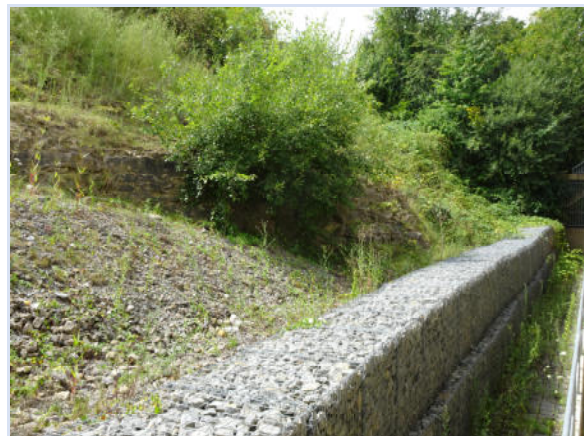
Foto 6: Blick auf die Gabionen Abgrenzung des Hanges im Süden des Gebäudes, mit Felsenbänder und kleiner Gesteinshalde direkt dahinter.
