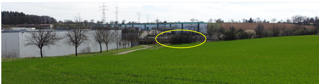
Foto 13: Blick nach Süden auf die Baumreihe entlang der Spedition am landwirtschaftlichen Weg und auf die Gehölze, die im Rahmen des Baus des Feuerwehrareals gefällt werden (geschütztes Biotop).
