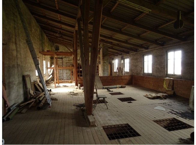
Abbildung 5: Dachstock Alte Mühle
