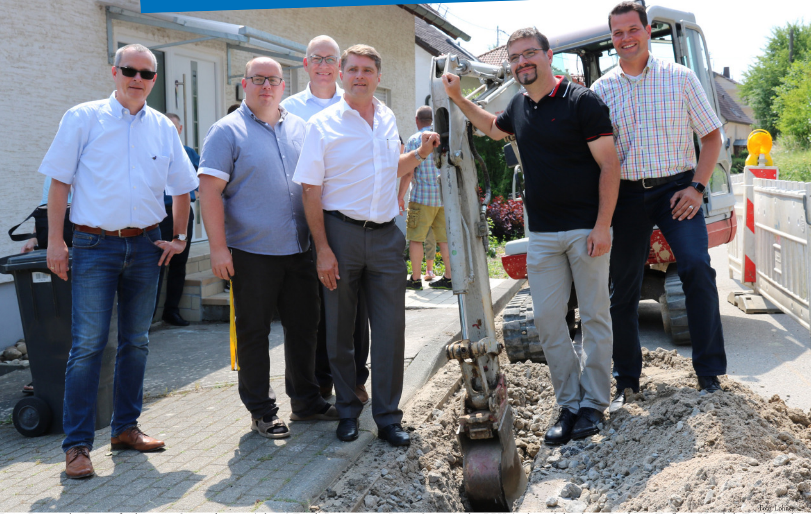
Beim Beginn der Baumaßnahmen in Sprantal waren (v.l.n.r.) Frank Bonnemeier, Leiter Strategie der BBV Andreas Schönberg, Bauleiter Tiefbau, Hendrik Ertel, Bauleiter Hausanschlüsse, beide von der SchönerTel GmbH, Oberbürgermeister Wolff, Ortsvorsteher Thorsten Wetzels, Sprantal und Ortsvorsteher Aaron Treut, Ruit dabei.
