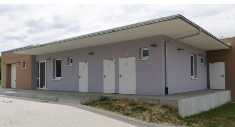
Das neue Sanitär- und Umkleidegebäude in Diedelsheim.
