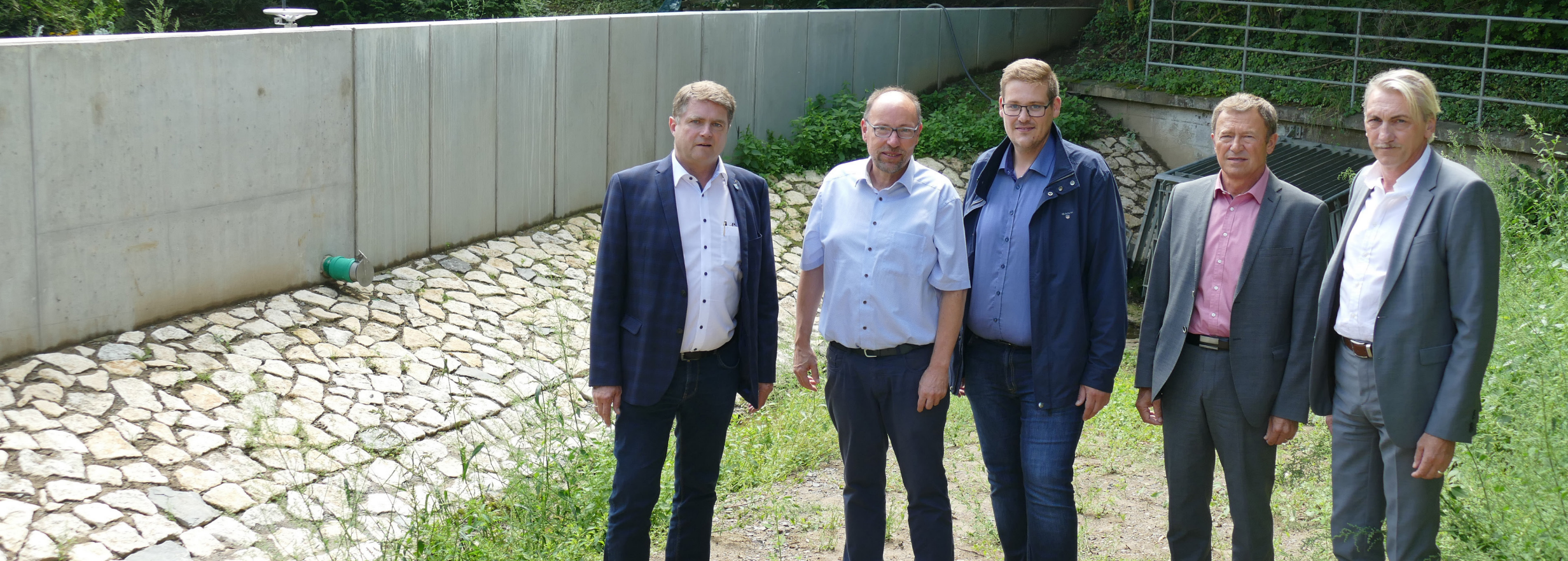
Mit Gölshausen (9) wurde in dieser Woche eine weitere Hochwasserschutzmaßnahme übergeben: (v.l.) Oberbürgermeister Martin Wolff, Helmut Petri und Fabian Dickemann vom Tiefbaumteam der Stadt Bretten, Stadtkämmerer Wolfgang Pux und der Leiter des Bauamtes Karl Velte.
