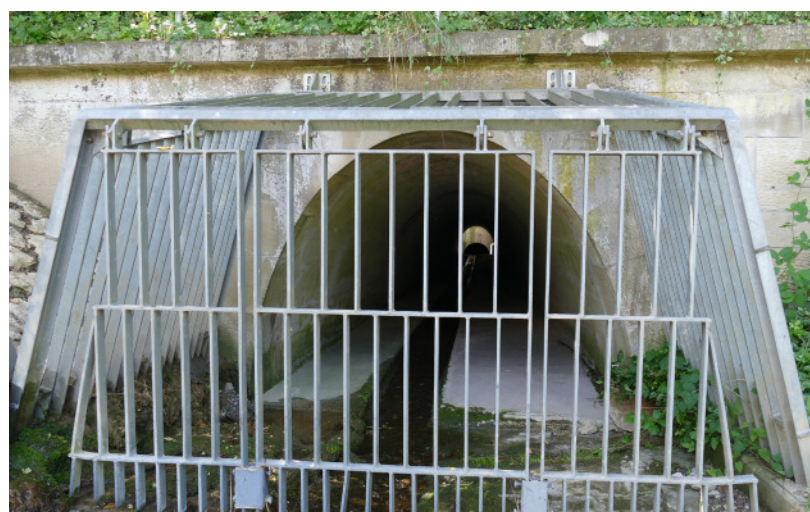
Rechen an den beiden Kanalenden sorgen auch bei Starkregen dafür, dass der Durchlass offen bleibt.
