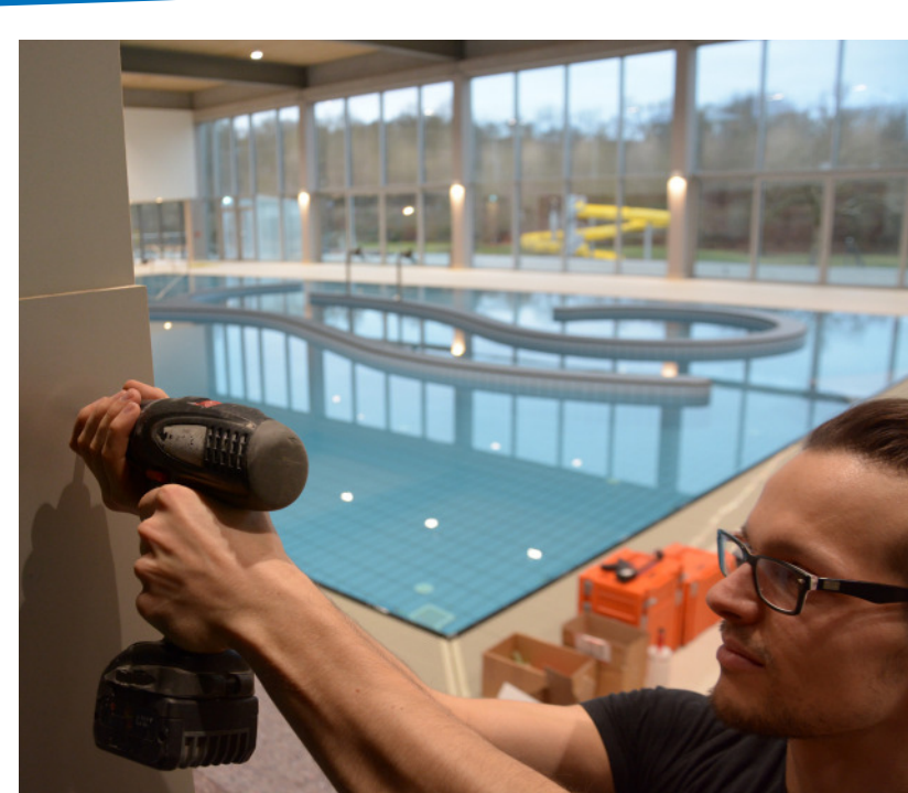
Bald ist der Umbau fertig. Die Handwerker erledigen die letzten Arbeiten.
