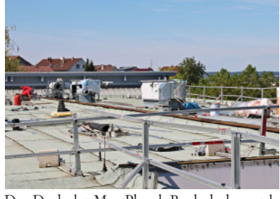
Das Dach der Max-Planck-Realschule wurde umfassend saniert und die gesamte Flachdachfläche von 1.800 m² erneuert. Ebenfalls wurde die auf dem Dach installierte Be- und Entlüftungsanlage erneuert. Kosten der Maßnahme: 250.000 Euro.
