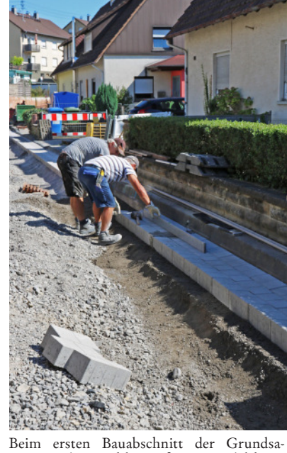
Beim ersten Bauabschnitt der Grundsanierung der Kechlerstraße in Diedelsheim werden die Ver- und Entsorgungsleitungen erneuert. Die bestehenden Kanalleitungen werden ausgetauscht und aufdimensioniert. Ebenso werden die Stadtwerke ein Leerrohr für die Breitbandversorgung verlegen. Auch die Straßenbeleuchtung wird im Zuge der Arbeiten erneuert. Kosten der Maßnahme: 550.000 Euro.
