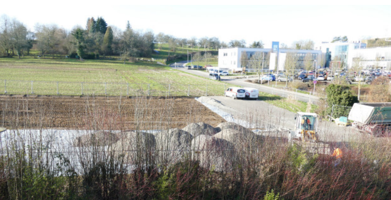
Auf dem für die Erweiterung geplanten Gelände rollen bereits die Bagger. Hinter den jetzigen Bürogebäuden entsteht zunächst ein Übergangsparkplatz. Der Großteil der Bauarbeiten startet dann Anfang 2020.
