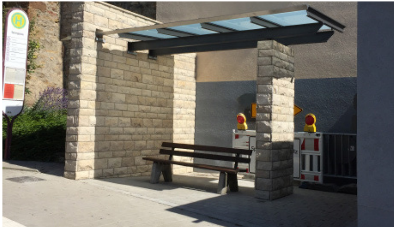
Im Rahmen des Mobilitätskonzepts der Stadt Bretten wurde die windgeschützte Buswarte in der Sporgasse mit Natursteinen verkleidet und mit einem Stahl-Glas-Dach versehen.
