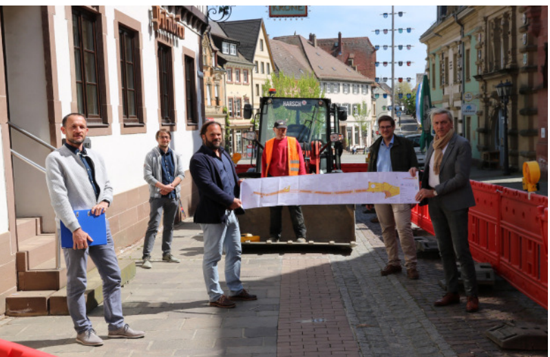
Stadtbauamtsdirektor Karl Velte (rechts) und Projektleiter Fabian Dickemann (2. von rechts) stellen gemeinsam mit Florian Seyboth, dem technischen Leiter Tiefbau der Fa. Harsch und weiteren Mitarbeitern der Fa. Harsch und der ISTW Planungsgesellschaft die Maßnahmen der Bauarbeiten in der Fußgängerzone vor.
