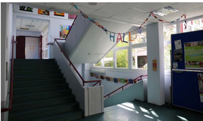
Dem Treppenhaus der Schillerschule wurde ein neuer Anstrich verpasst.
