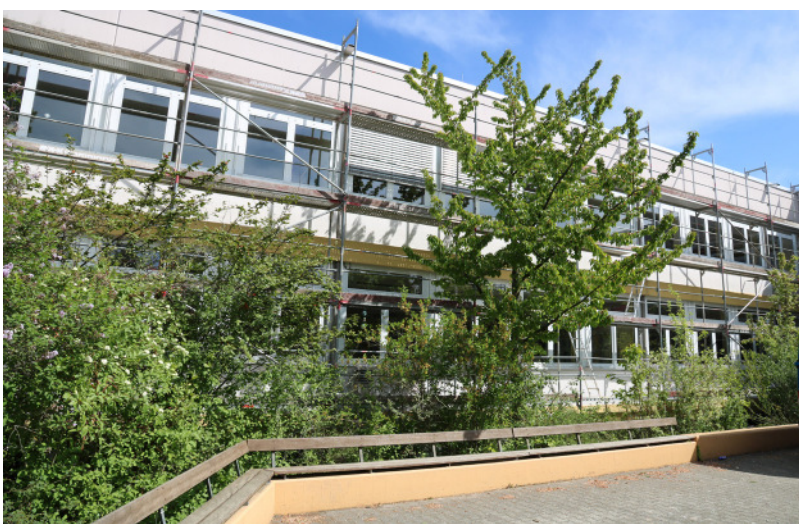
Das Gerüst steht bei der Max-Planck-Realschule werden sowohl Außenarbeiten an der Fassade als auch Innenarbeiten durchgeführt.
