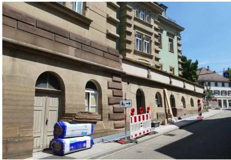
Die Toilettenanlage an der Pforzheimer Straße, hinter dem Alten Rathaus, wird derzeit saniert und umgebaut.
