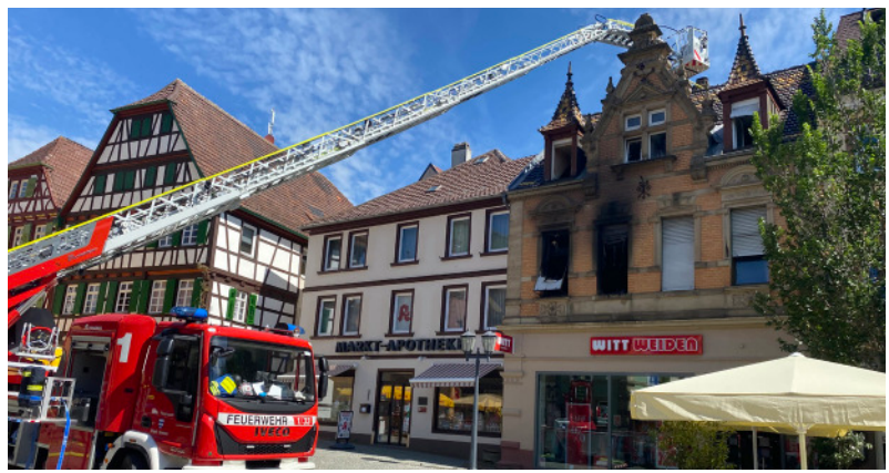
Offensichtlich durch Brandstiftung wurde am Wochenende das denkmalgeschützte Gebäude am Marktplatz 7 beschädigt.
