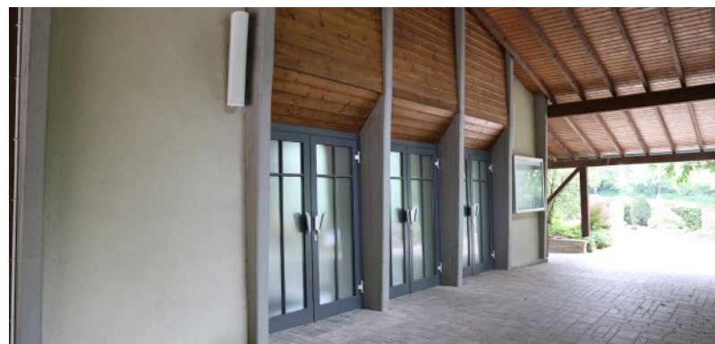
Neben der Montage einer neuen Lautsprecheranlage wurde auch eine beleuchtbare Schautafel im Eingangsbereich der Aussegnungshalle angebracht.
