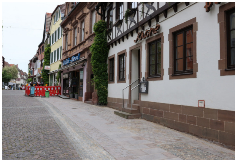
Vor dem Hotel Krone wurden die Arbeiten in der Fußgängerzone bereits abgeschlossen.
