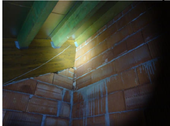
Dachboden mit Porotonsteinen zur Raumabtrennung
