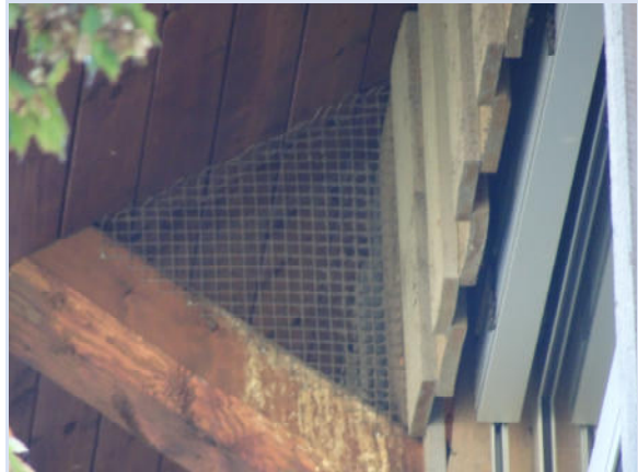
Draht als Taubensperre an den Querbalken Ostseite
