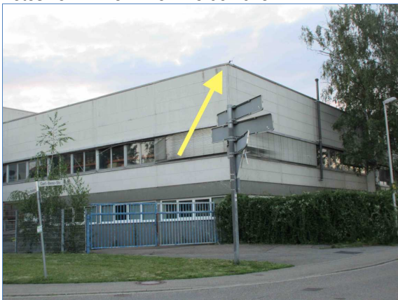
11: Blick auf das Firmengebäude der Schreinerei mit der Lage der Wochenstube der Zwergfledermaus.
